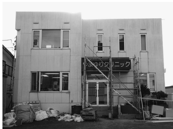
改修中のやまゆりクリニック
