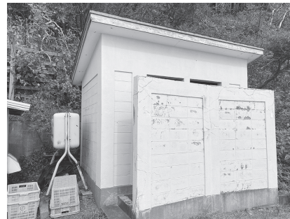
今年度解体した浦和公衆トイレ (昭和54年8月建設)
